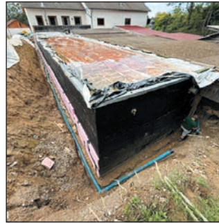
Einblicke in den Umbau im Außenbereich...
